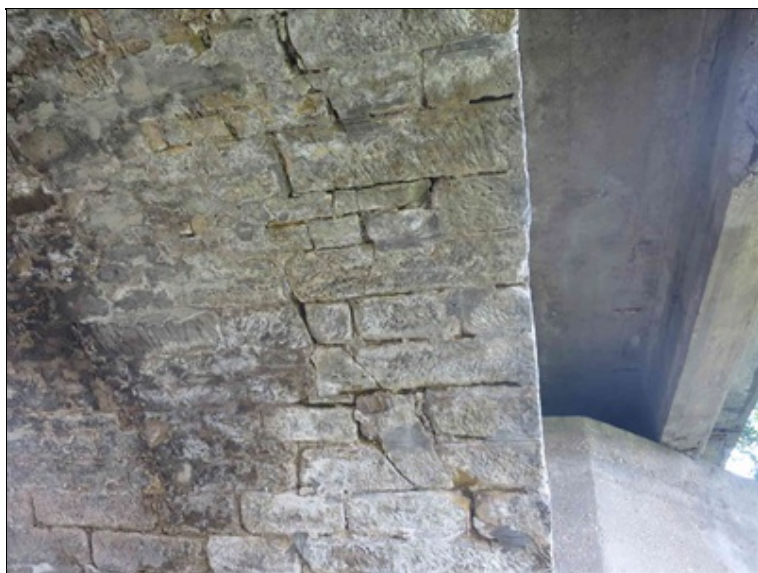
pole 3 - vyplavené spárování, degradace kvádrů zdiva a začínající podélné trhliny na spodním líci klenbového pasu podél levé hrany
