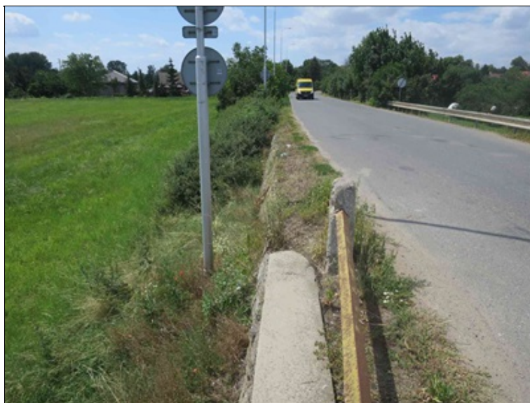
před opěrou 1 na mostní objekt navazují dlouhé opěrné zdi
