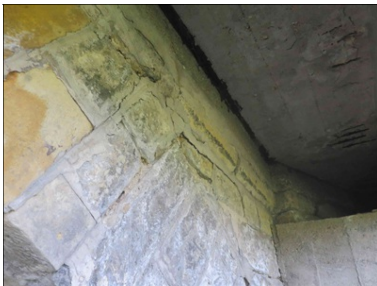
pole 1 - mírné vybočení zdiva levé poprsní zdi nad opěrou 1 vně
