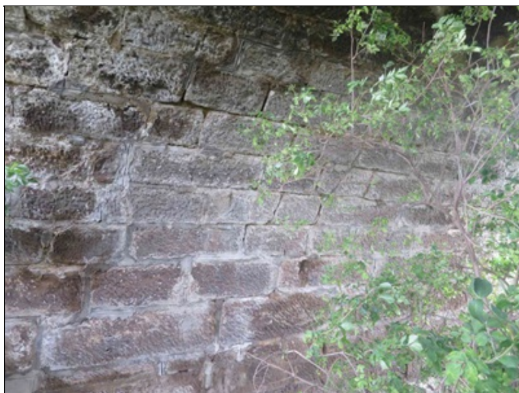
pole 2 - poruchy spárování zdiva klenbového pasu
