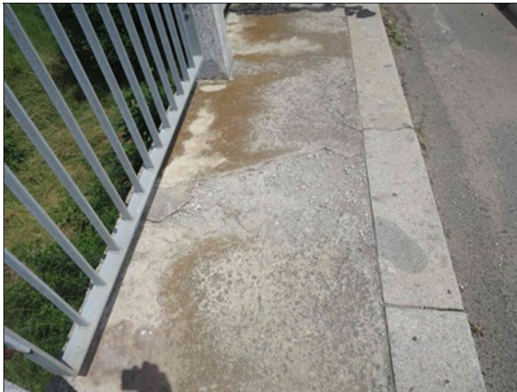
degradace betonu hcodníku
