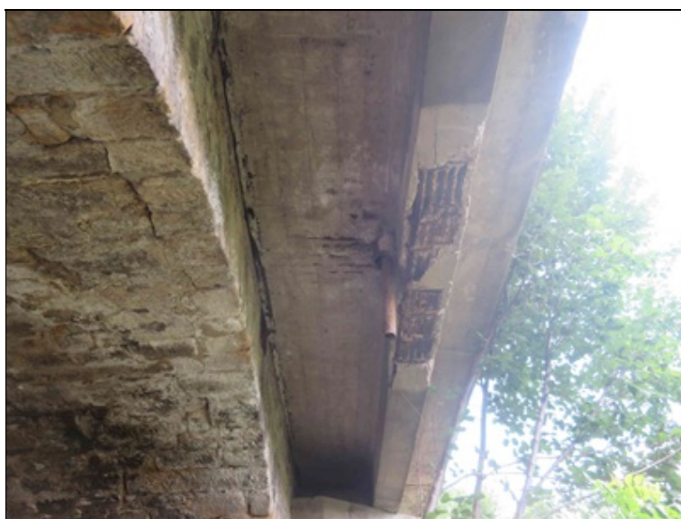
pole 4 - detail rozpadu železobetonové konstrukce pravého rozšíření
