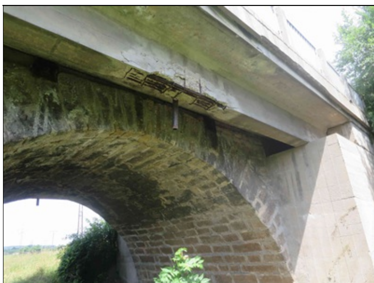
pole 5 - rozpad železobetonové konstrukce pravého rozšíření
