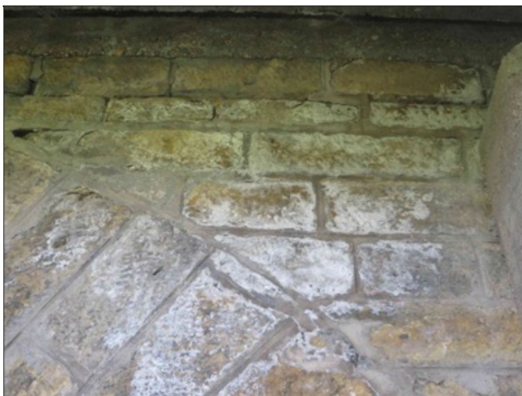
pole 3 - výrazné zasolení zdiva levé poprsní zdi u P3
