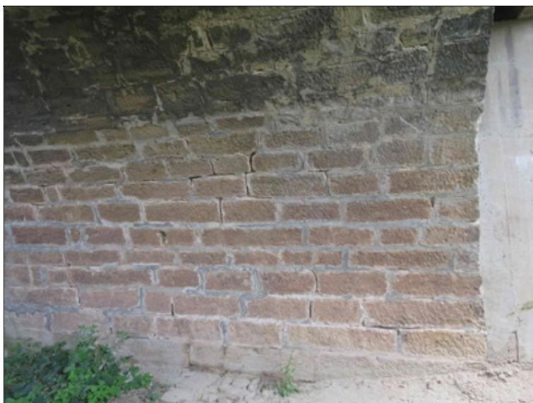
pole 5 - pohled klenbového pasu nad O6 - i přes prováděnou běžnou údržbu včetně spárování dochází k odpadávání oprav a otevírání spár
