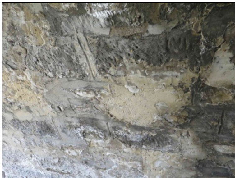
pole 1 - detail líce zdiva klenbového pasu v oblastech provedených oprav
