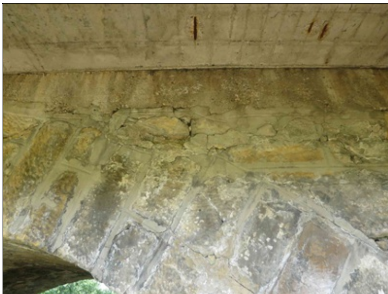
pole 1 - poruchy zdiva pravé poprsní zdi pod železobetonovou konstrukcí pravého rozšíření u P2
