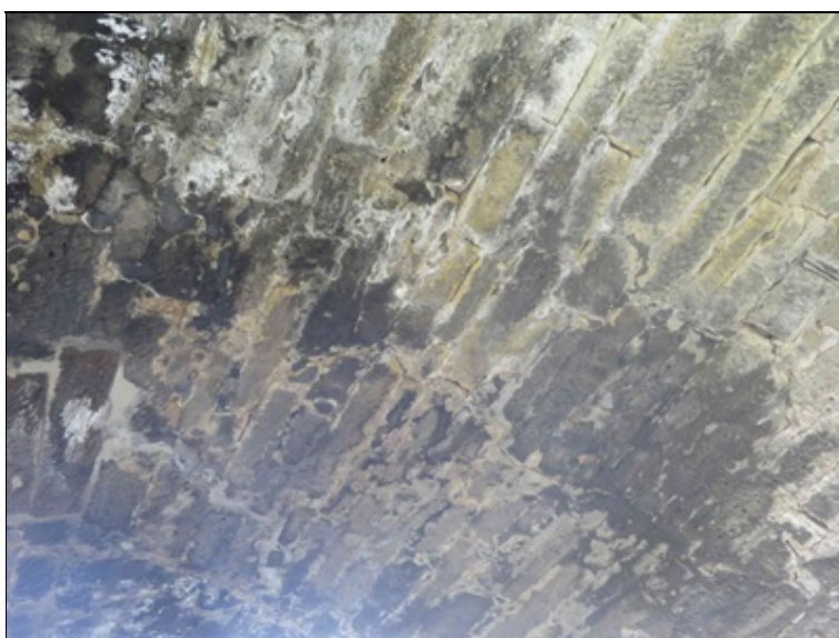
pole 5 - zasolení zdiva klenbového pasu ve vrcholu
