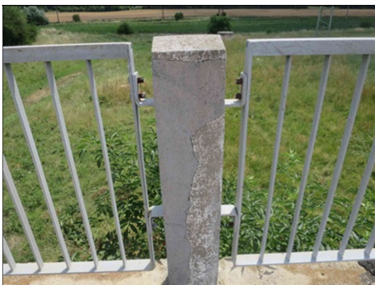
separace sanace sloupku zábradlí
