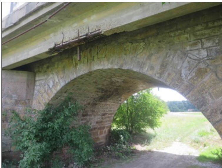
pole 3 - pohled na levou stranu - totální rozpad železobetonové konstrukce rozšíření
