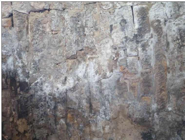
pole 4 - pohled zdiva klenbového pasu při pravé hraně - výrazné zasolení zdiva, poruchy spárování, výrazné podélná trhlina
