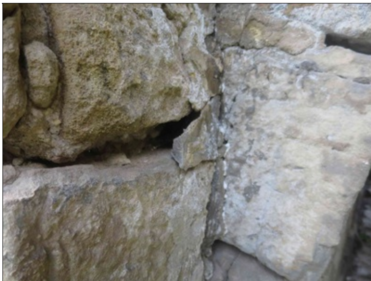
pole 5 - detail typické poruchy zdiva - dodatečné spárování pohledové části spar je nefunkční - dochází k separaci malty od kamene zejména díky rozpadu povrchu pískovce
