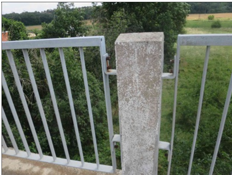
koroze spojovacích prvků zábradlí
