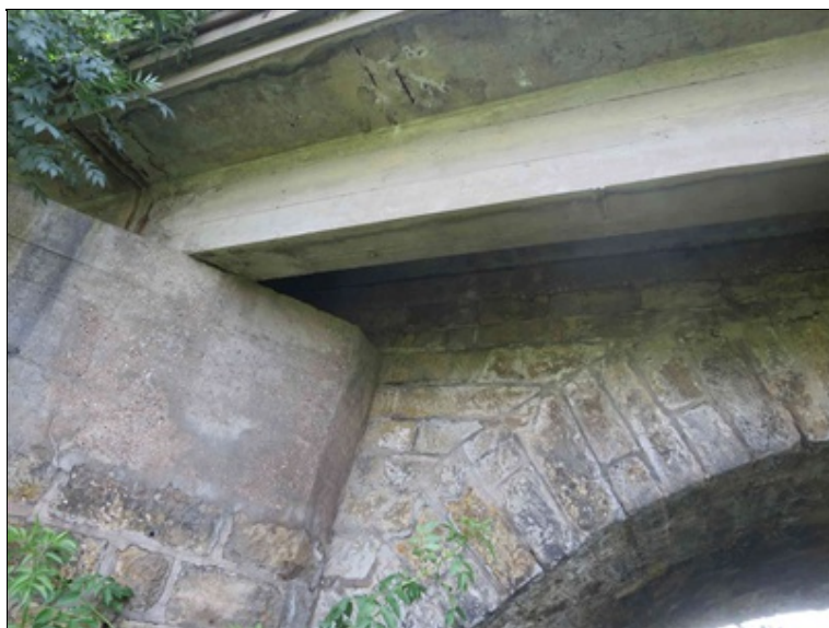
pole 2 - uložení konstrukce levého rozšíření na P3
