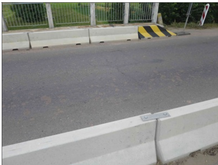
trhliny v krytu vozovky
