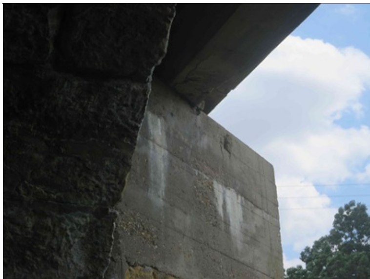
pilíř 3 - pravé rozšíření dříku z prostoru pole 2 - detail betonového zhlaví
