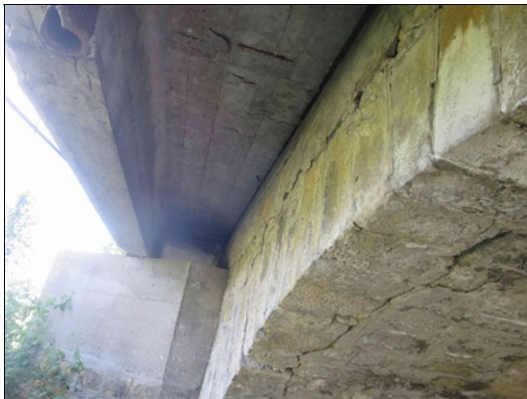
pole 1 - uložení levé betonové konstrukce rozšíření na pilíř 2
