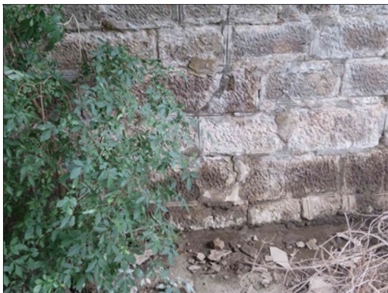
pole 2 - vztlínající vlhkost na líci zdiva dříku P2 nad terénem.
