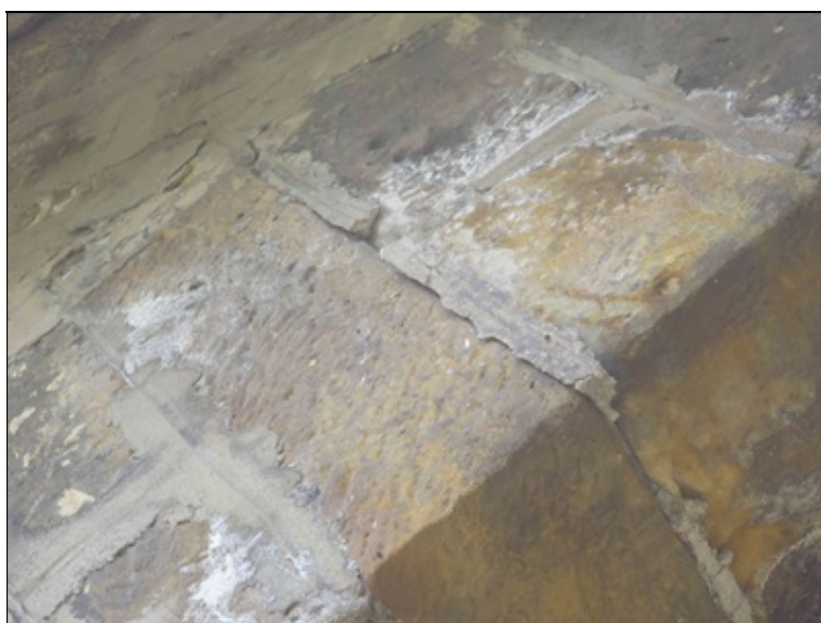
pole 3 - detail typické poruchy zdiva - dodatečné spárování pohledové části spar je nefunkční - dochází k separaci malty od kamene zejména díky rozpadu povrchu pískovce
