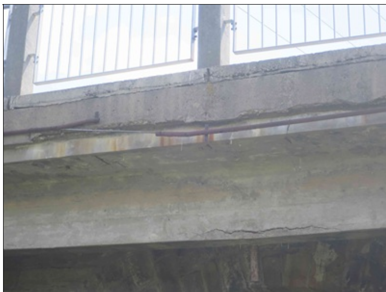
pole 5 - chránička zavěšená na levé římse se rozpadá
