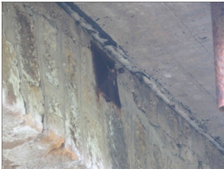
pole 4 - klenbový pas je sepnutý příčným táhlem ve vrcholu klenby
