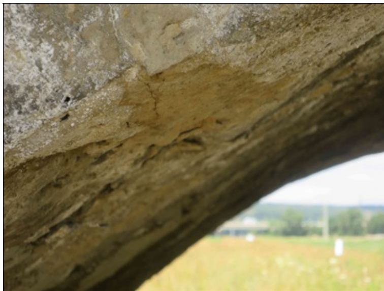
pole 1 - u klenbového pasu je patrna mírná deformace geometrie cca v 1/4 rozpětí
