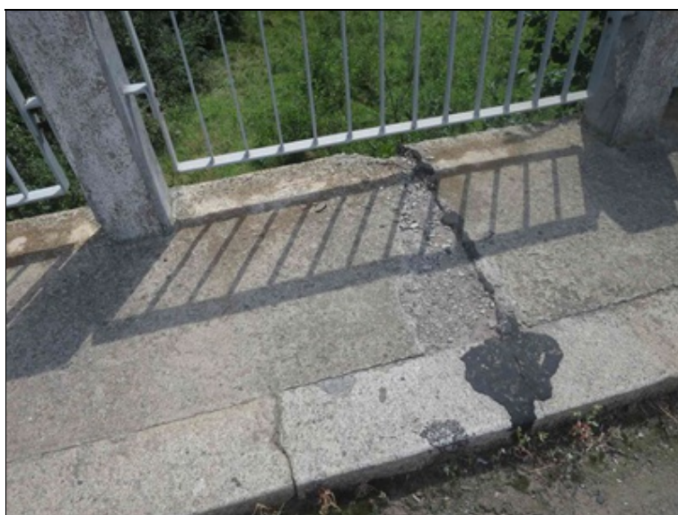
degradace betonu chodníku
