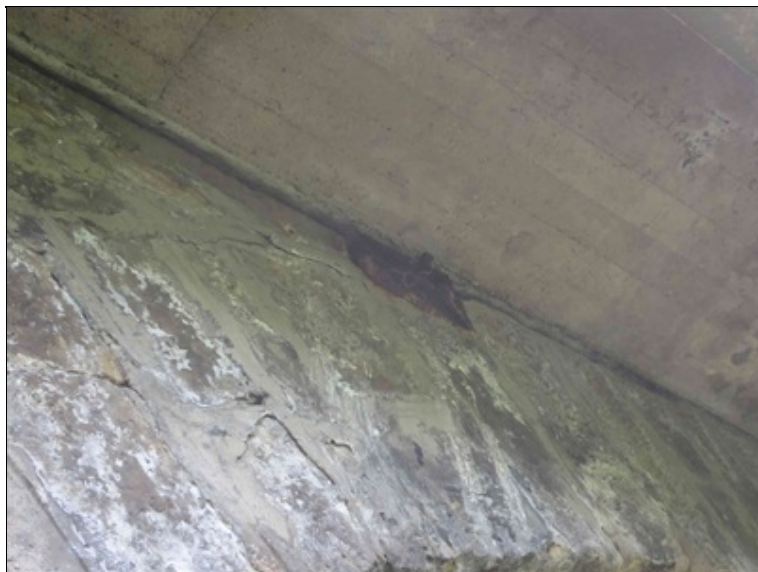
pole 5 - kotevní prvek příčného táhla na pravé straně
