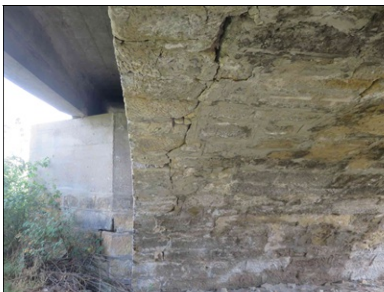
pole 1 - podélná trhлина na spodním líci klenbového pasu podél levé hrany směrem k P2
