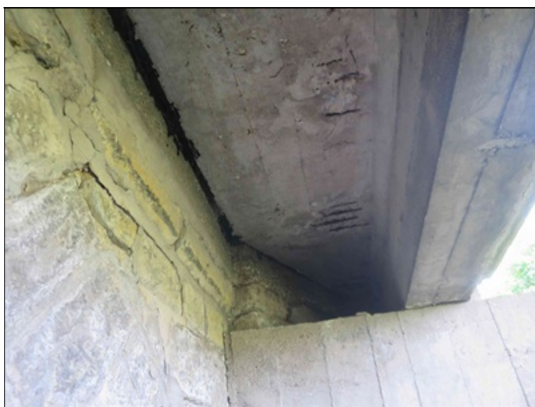
pole 1 - uložení levé betonové konstrukce rozšíření na opěru 1
