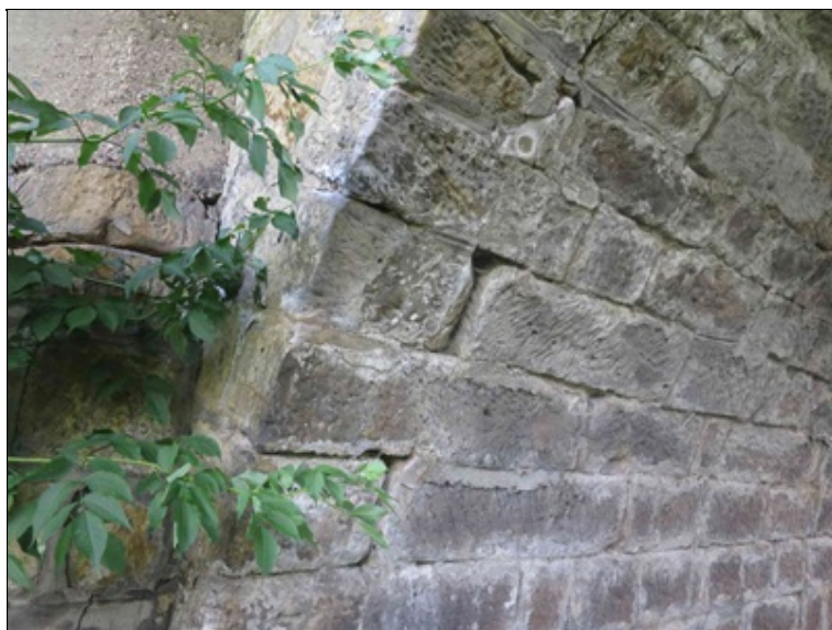
pole 4 - poruchy spárování zdiva klenbového pasu při levé hraně nad P5
