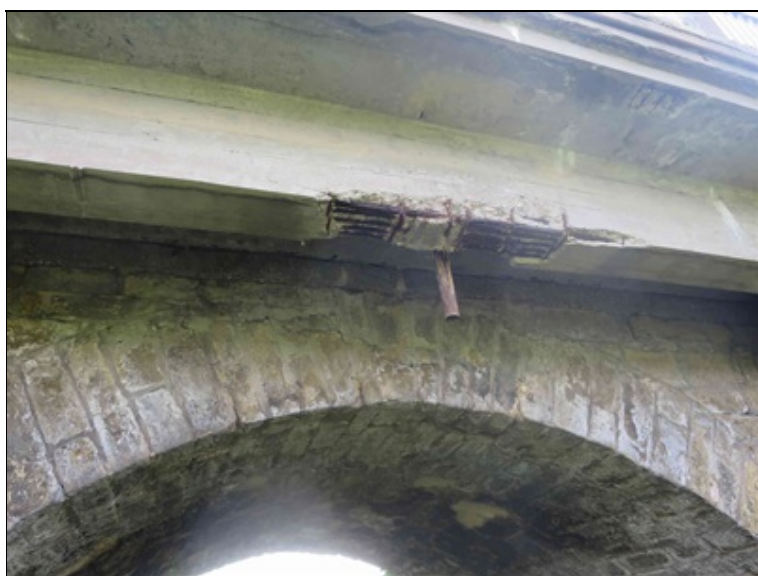
pole 2 - rozpad železobetonové konstrukce levého rozšíření
