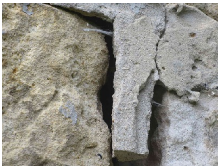
pole 4 - detail typické poruchy zdiva - dodatečné spárování pohledové části spar je nefunkční - dochází k separaci malty od kamene zejména díky rozpadu povrchu pískovce
