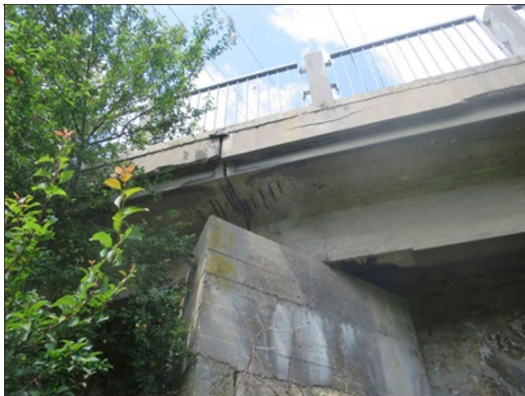
železobetonové konstrukce pravého rozšíření v oblasti dilatační spáry nad P4
