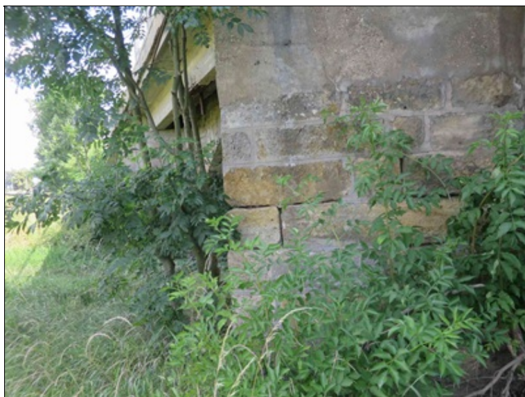
pilíř 3 - levé rozšíření dříku z prostoru pole 2 - výrazné poruchy spárování
