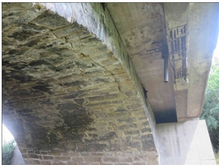
pole 5 - výrazná podélná trhlina ve zdivu klenbového pasu při pravé hraně
