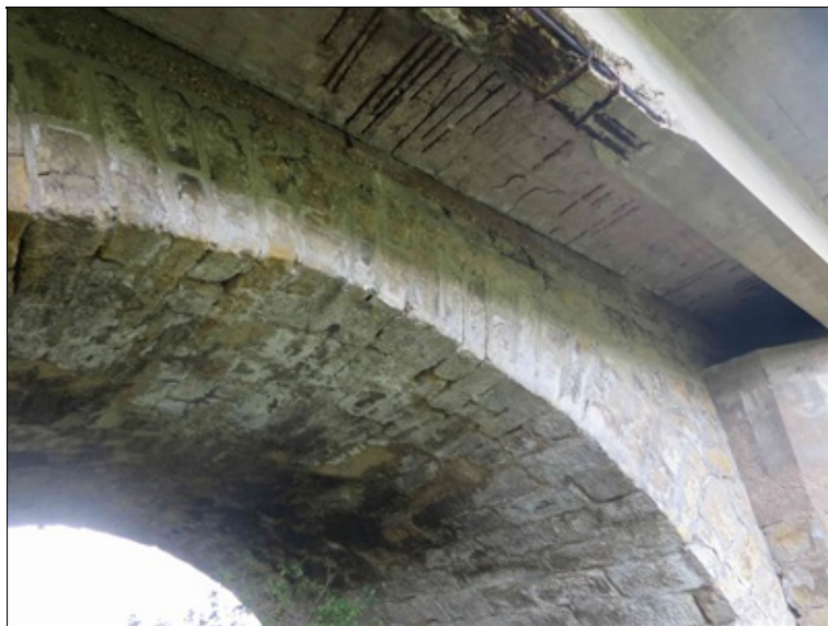
pole 2 - pravý bok klenbového pasu ve vrcholu klenby, rozpad železobetonové konstrukce pravého rozšíření
