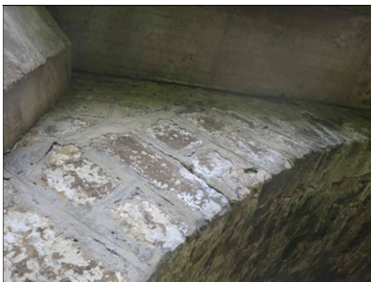
pole 5 - zasolení zdiva na pravém boku klenbového pasu nad P5
