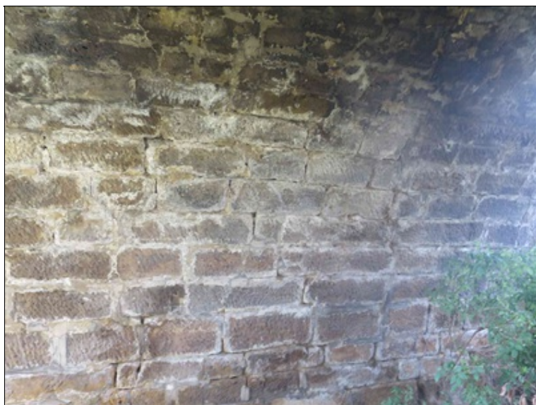
pole 4 - poruchy spárování zdiva klenbového pasu, výrazné zasolení v oblastech spár mezi kvádry
