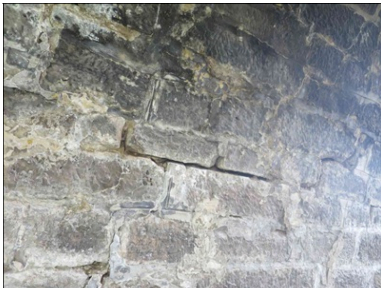
pole 5 - hloubkový rozpad spárové malty a degradace kvádrů zdiva klenbového pasu nad P5
