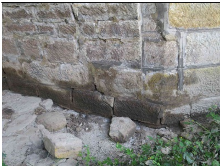
pole 5 - silně zvlhlé zdivo P5 při levé straně
