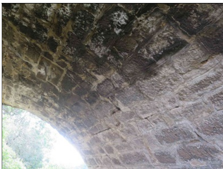
pole 5 - mírná deformace spodního líce klenbového pasu v 1/4 rozpětí
