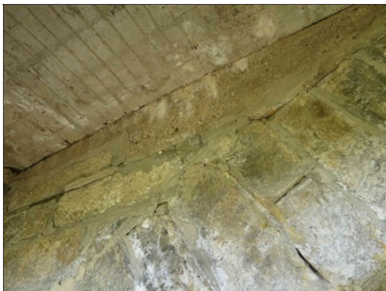
pole 1 - uložení konstrukce pravého rozšíření na pravou poprsní zeď nad O1
