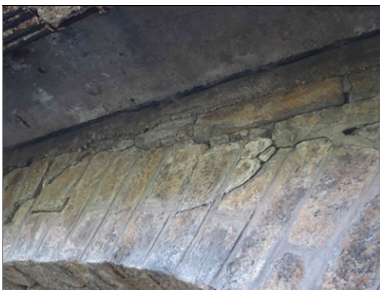
pole 3 - rozpad zdiva levé poprsní zdi a trhliny na levém boku klenbového pasu
