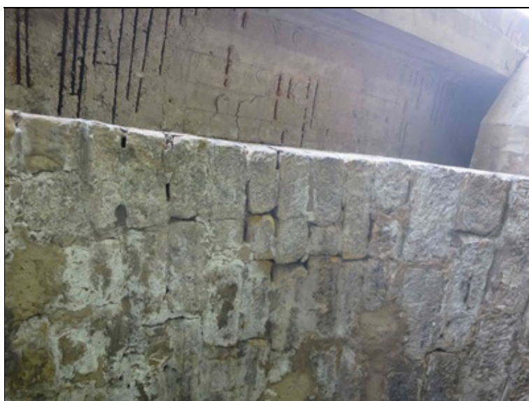
pole 2 - pohled pravé části klenbového pasu - výrazné stopy po zasolení, otevřené spáry s vyplavenou spárovou maltou, lokálně i podélné trhliny ve zdivu
