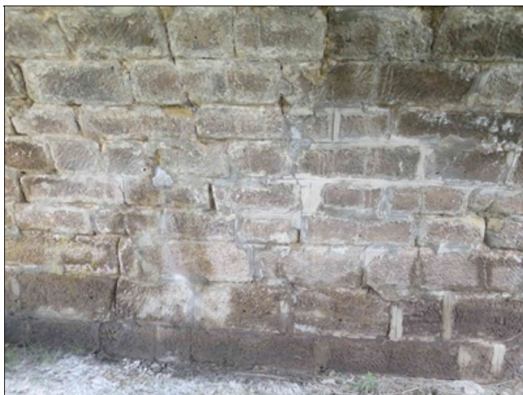
pole 3 - poruchy spárování zdiva v patě klenbového pasu nad P3
