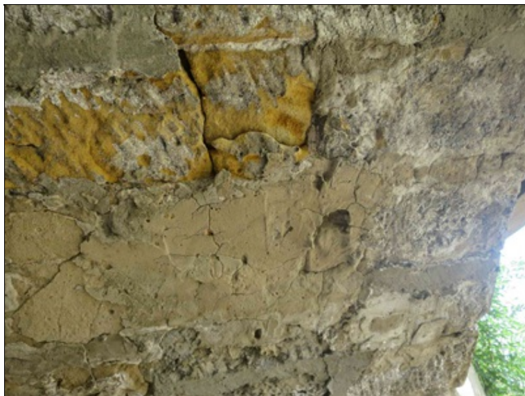
pole 1 - pod opravami jsou patrné podélné trhliny, resp. nevyplněné spáry
