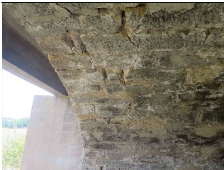
pole 1 - podélná trhlina ve zdivu klenbového pasu souběžně s pravou hranou, poruchy spárování, lokálně již dochází k hloubkové degradaci kvádrů v okolí trhliny
