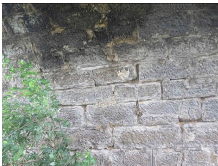
pole 3 - hloubková degradace spárové malty a zčernalé krusty na spodním líci zdiva klenbového pasu
