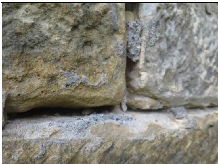
pilíř 4 - pravé rozšíření dřívku z prostoru pole 4 - detail poruch spárování
