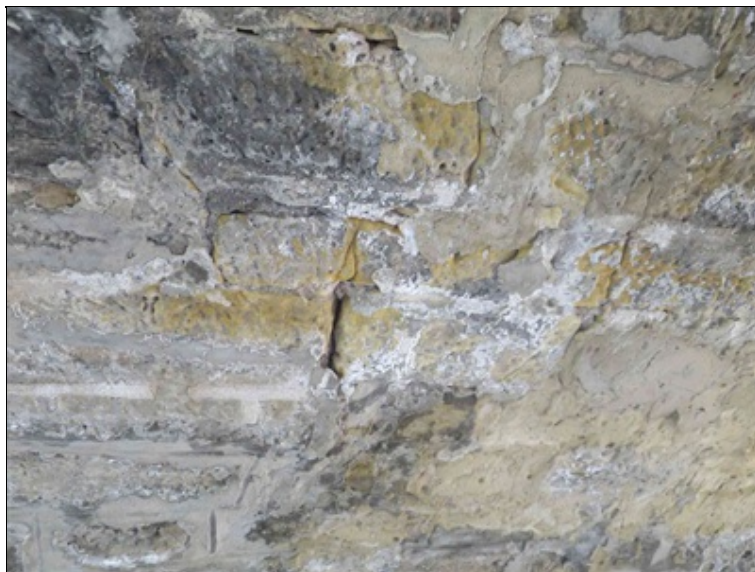
pole 1 - zasolení zdiva klenbového pasu ve vrcholu, poruchy spárování
